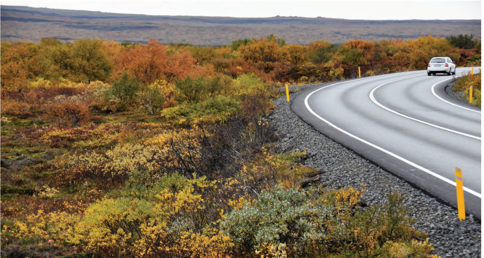
Mynd 23.12. Vandaður frágangur eftir vegagerð í Þjóðgarðinum á Þingvöllum. Torfur sem áður voru í vegarstæðinu voru notaðar við endurheimt á náttúrulegu gróðurfari í vegkantinum til að lágmarka umhverfisáhrif vegagerðarinnar. Landbúnaðarháskóli Íslands (Ása L. Aradóttir o.fl.) hefur unnið með Vegagerðinni við að þróa þessa aðferð (sjá Steinunni Garðarsdóttur 2021). Mynd: Ása L. Aradóttir.
